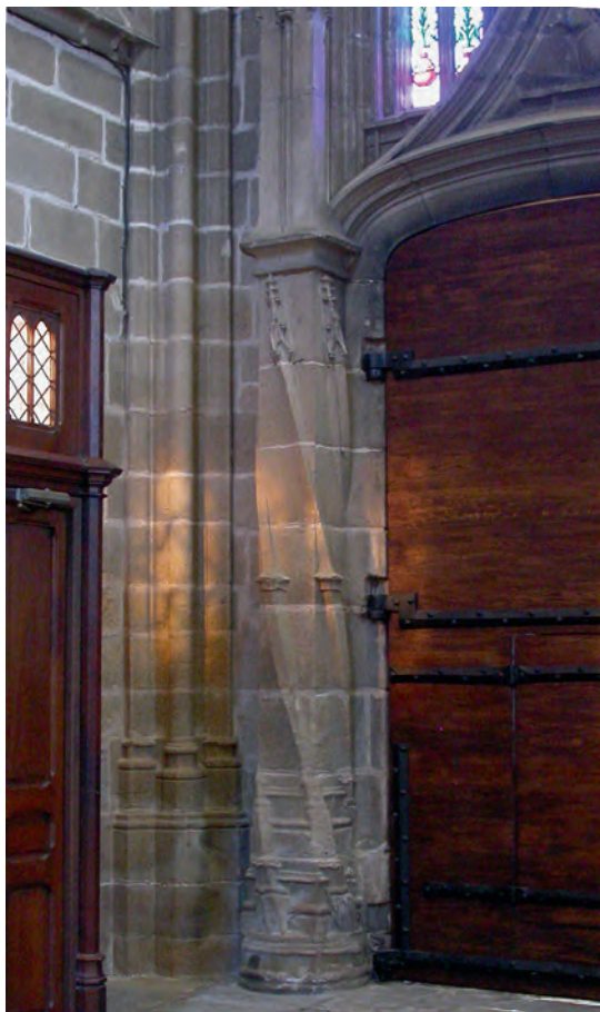
FIG. 4. REVERS DE LA FAÇADE DU BRAS NORD, support de section carrée à baguettes torsadées. Cl. J. Dubois.
