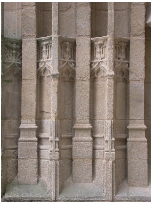
FIG. 6. PORTAIL SAINT-JEAN, CONTREFORT NORD-OUEST, détail d'un socle des niches du premier registre, arcatures aveugles vues de côté. Cl. J. Dubois.
